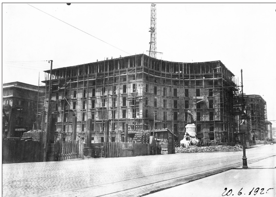
Fig. 10. Il lotto M in costruzione. 20 giugno 1925.
