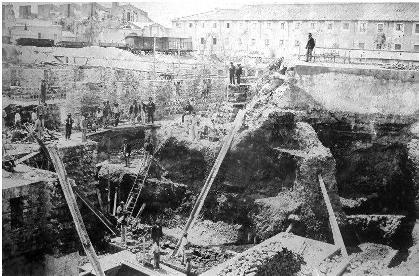
ABr, fotografia non catalogata (inedita), relativa probabilmente al cantiere del Ministero delle Finanze a Roma (1872-1876), databile quindi poco dopo il 1872 (si scavano le fondazioni). Si nota la ferrovia per il trasporto dei materiali, i resti archeologici in fondo (da identificare con i resti delle terme di Diocleziano, la basilica di S. Maria degli Angeli e Martiri) ed i resti archeologici nel sottosuolo.
