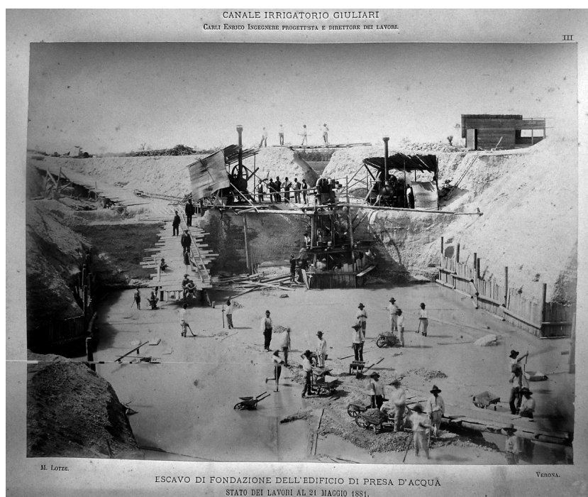
ABr, Album del Canale Camuzzoni-Giuliani a Verona, fotografo M. Lotze, tavola III. I scavi di fondazione dell'edificio di presa dell'acqua. Stato dei lavori al 21 maggio 1881.
