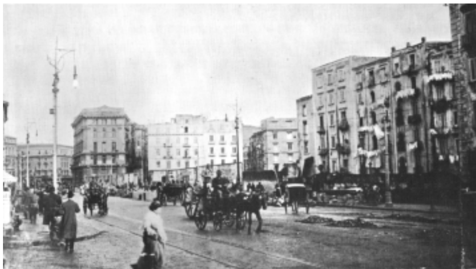
Fig. 4. Via Agostino Depretis durante i lavori del Risanamento: sullo sfondo è visibile piazza Giovanni Bovio con uno dei nuovi edifici.
