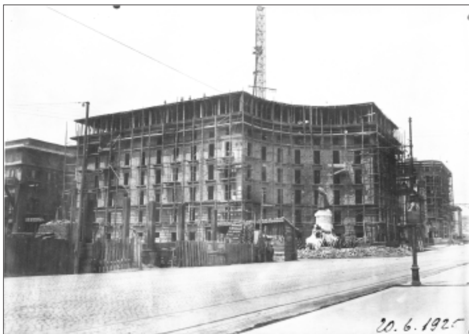
Fig. 10. Il lotto M in costruzione. 20 giugno 1925.
