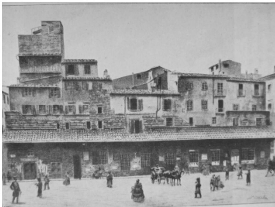
Fig. 1. La “tettoia dei Pisani” demolita per la realizzazione del palazzo Lavisson, 1870 c. (PESCI, 1904).
