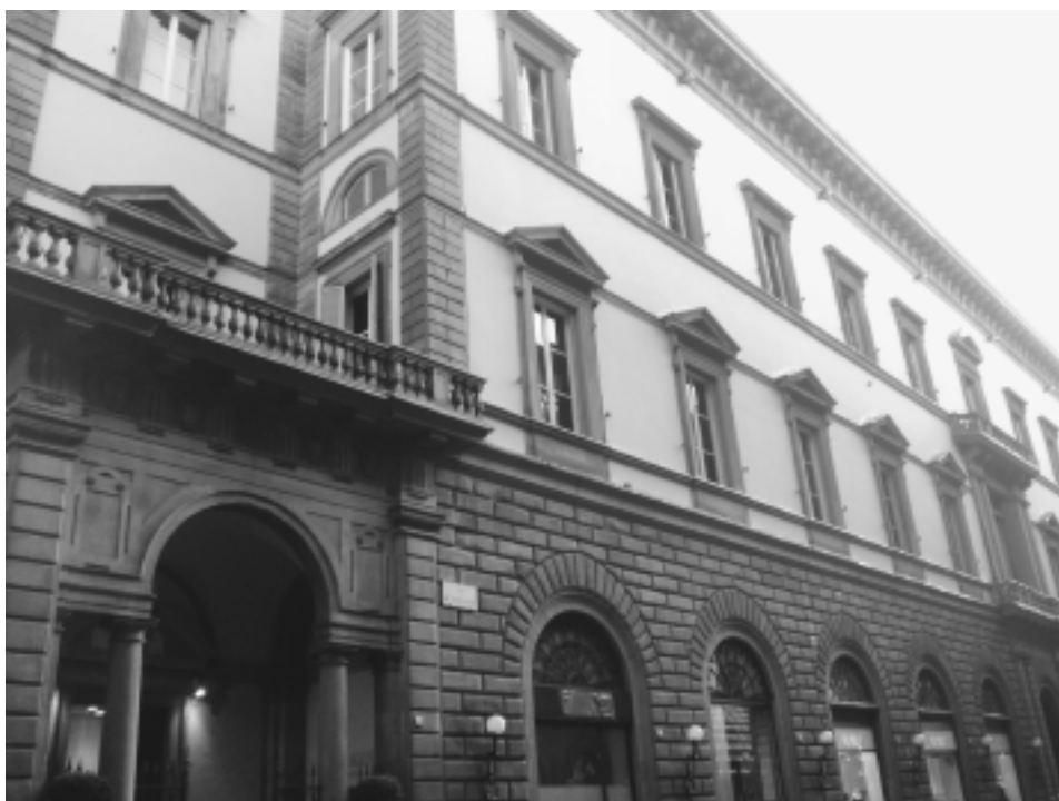
Fig. 14. Firenze, Facciata di palazzo Corsi-Salviati in via Tornabuoni , oggetto di una trattativa di acquisto delle Generali nel 1904 (fotografia dell'autrice).
