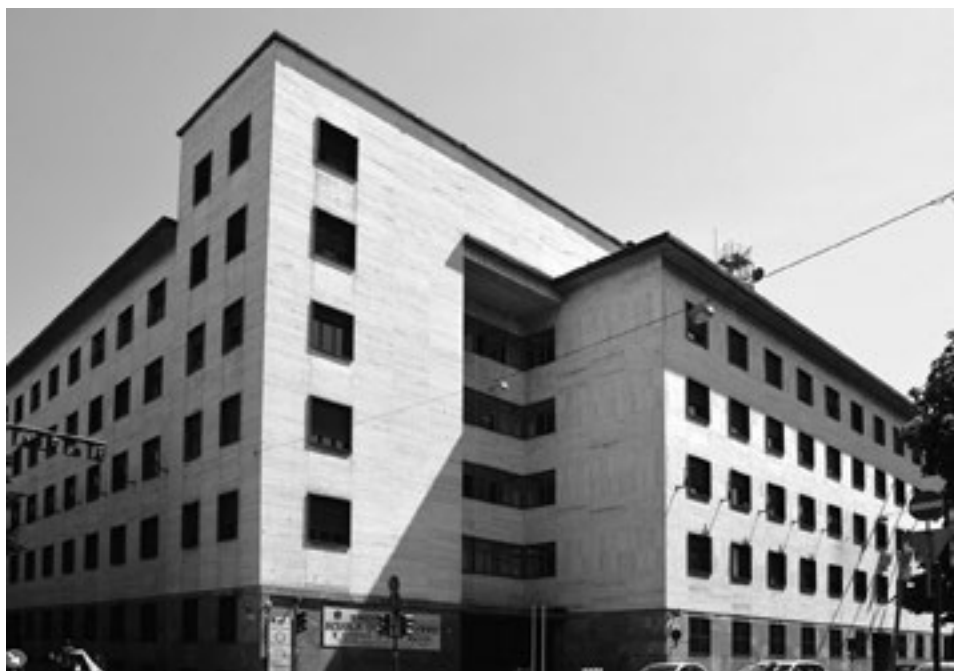
Fig. 10. L'edificio degli ex Alti Comandi.
