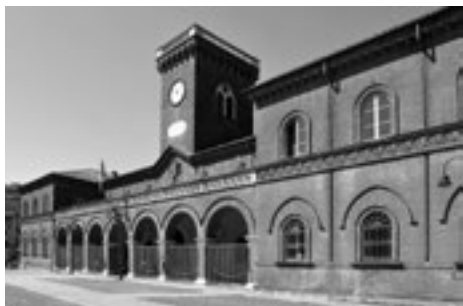
Fig. 21. L'ex palazzina direzionale.
