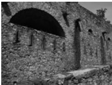
Fig. 6. Dettaglio delle murature esterne.
