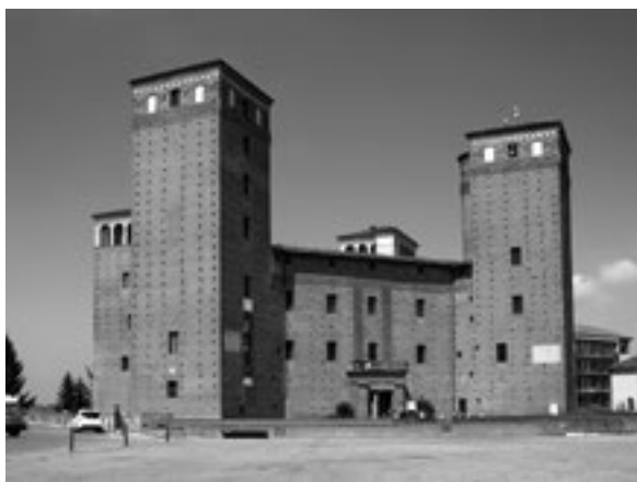
Fig. 5. Fossano, il castello visto da est.
