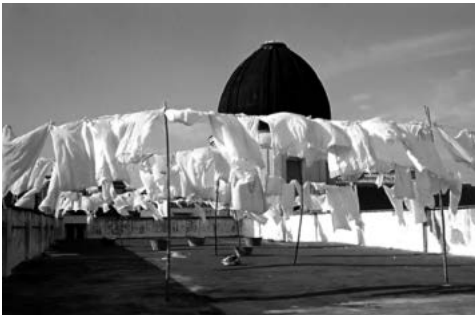
Fig. 8. Le coperture dell'edificio tra via Santa Teresa agli Scalzi e salita San Raffaele.
