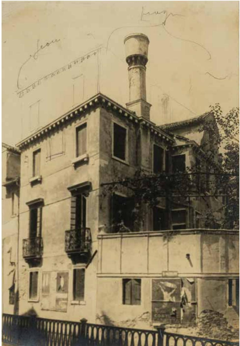
*Fig. 114. Ing. Mario D'Oria, Schizzo su stampa fotografica del progetto di sopraelevazione a Castello su Fondamenta dell'Osmarin, 26 settembre 1925 (AMV, 1921-25, IX/1/10, prot. 50787). Malgrado l'edificio non fosse presente nell'elenco degli edifici sottoposti a tutela della Soprintendenza all'arte medievale e moderna di Venezia, sul progetto interviene il Soprintendente, l'ing. Ferdinando Forlati, nel tentativo di salvaguardare il caratteristico comignolo posto sul tetto.*
