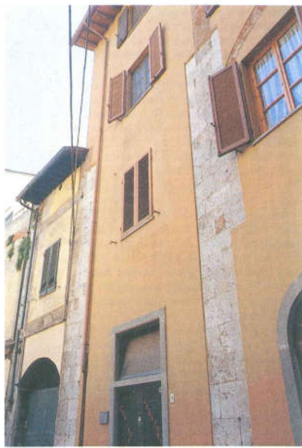
Pietrasanta, via G. Mazzini nn. 9-11: L'arco di mattoni del pianterreno ammorsa con la struttura a pilastri di pietra preesistente.
