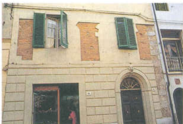
Pietrasanta, via G. Mazzini nn. 9-11: L'arco di mattoni del pianterreno ammorsa con la struttura a pilastri di pietra preesistente.
