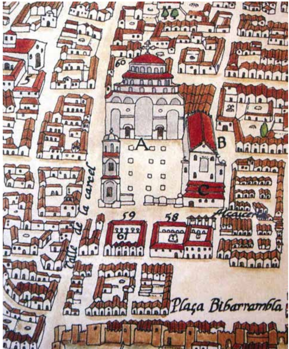
11. Plataforma de Granada, dibujo de Ambrosio de Vico (hacia 1613). Detalle mostrando la gran catedral renacentista en construcción: A. Nave de la catedral, solo la cabecera con la gran cúpula está finalizada; B. Capilla Real (construida entre 1504 y 1525); C. Naves de la antigua mezquita con el minarete a la izquierda. Archivo Municipal ayuntamiento de Granada.
