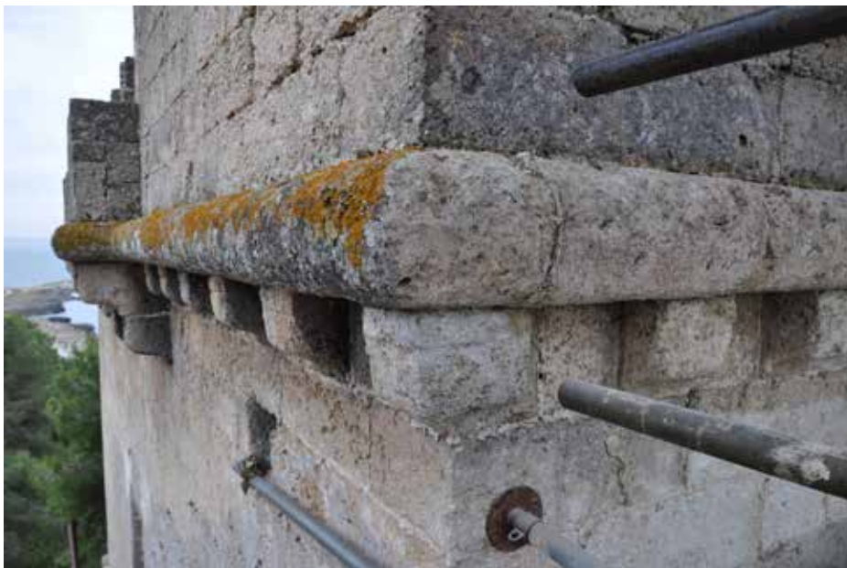
9. Nardò, Torre S Caterina, veduta della cornice superiore con beccatelli e caditoie, foto realizzata prima dei lavori di restauro degli anni 2014-2018.
