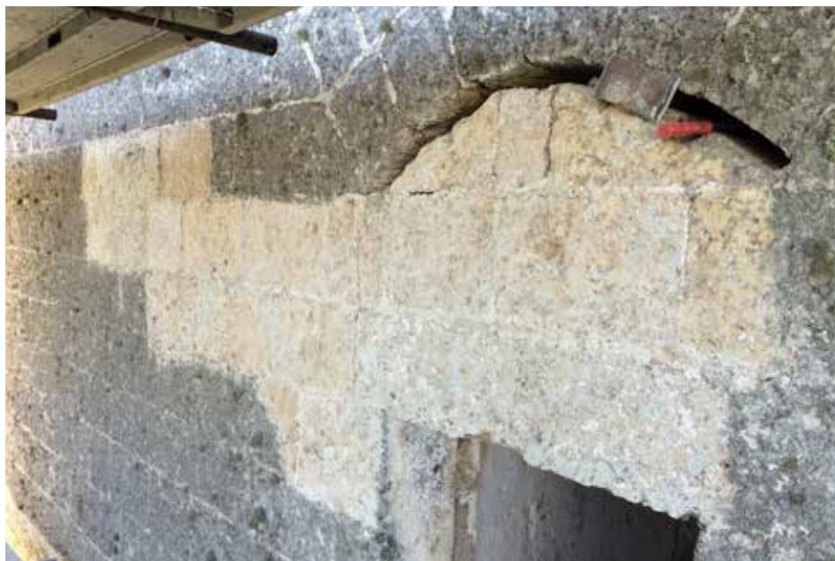
12. Nardò, Torre S. Caterina, veduta dei saggi di pulitura della cortina muraria a sud-ovest, foto realizzata durante i lavori di restauro, novembre 2014.
