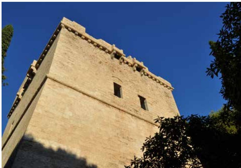
8. Nardò, Torre S. Caterina, veduta della cortina muraria a sud-ovest, foto realizzata dopo i lavori di restauro, luglio 2015.
