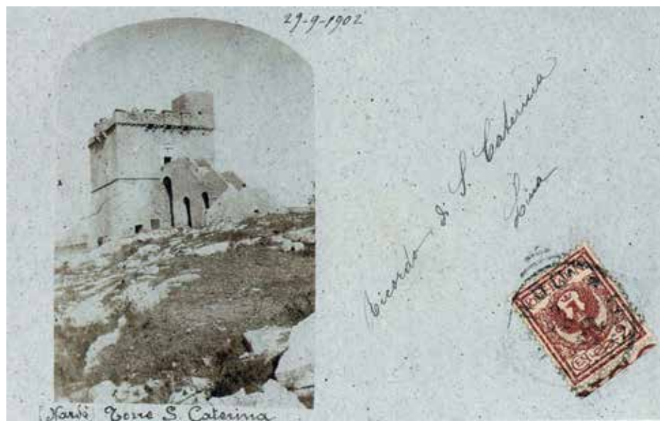
3. Nardò, veduta della Torre S. Caterina dalla parte dell'accesso con scalone d'accesso, 1902, cartolina d'epoca. La foto raffigura la Torre senza la piantumazione laterale: si vedono le caditoie integre e le aperture a piano terra per permettere l'accesso al vano stalla (archivio privato dell'autore).
