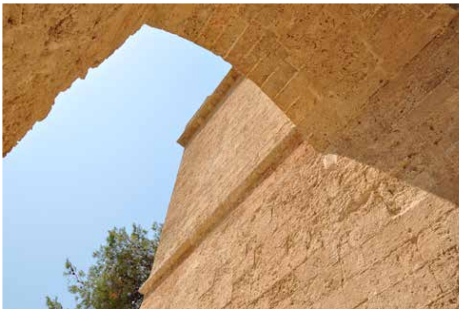
10. Nardò, Torre S Caterina, veduta della cortina dell'arco restaurato in sostituzione del ponte levatoio in legno, foto realizzata dopo i lavori di restauro, luglio 2015. L'arco fu realizzato dopo l'acquisizione della Torre da parte della famiglia Giulio avvenuta alla fine dell'800 quando il fortilizio e l'area circostante non aveva più alcuna funzione difensiva.
