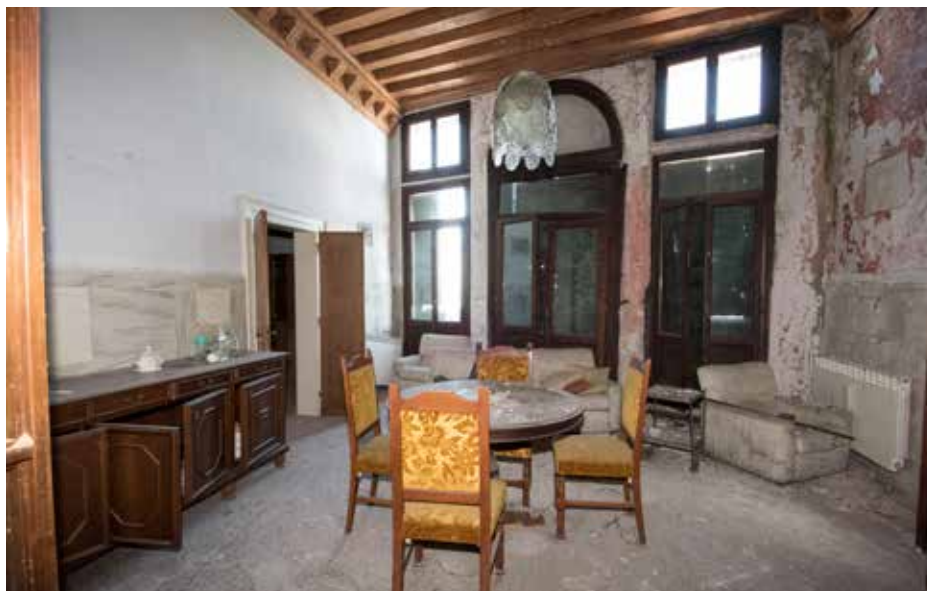
11. Il Salone al primo piano (palazzo ad ovest). Si notano perimetralmente i rivestimenti parietali marmorei e, in alto, la fascia perimetrale di mensoloni (produzioni della Kunsthaus F. Naager).
