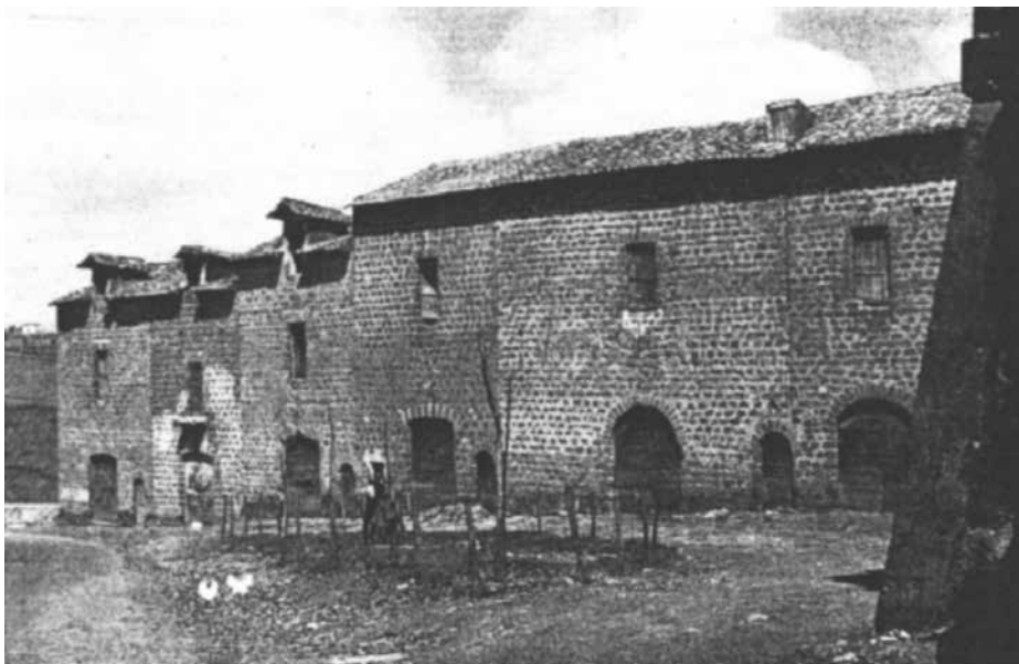
7. I fenili fuori di porta S. Martino, un'ulteriore espansione urbana.
