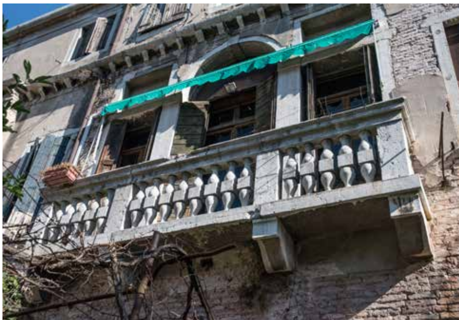
13. Palazzo ad ovest, vista giardino, dettaglio del poggiolo.
