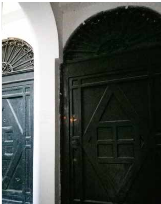
8. Dettaglio di porte con motivo decorativo a rombo, di cui una rinforzata con lamiera punzonata (primo piano, palazzo ad ovest).
