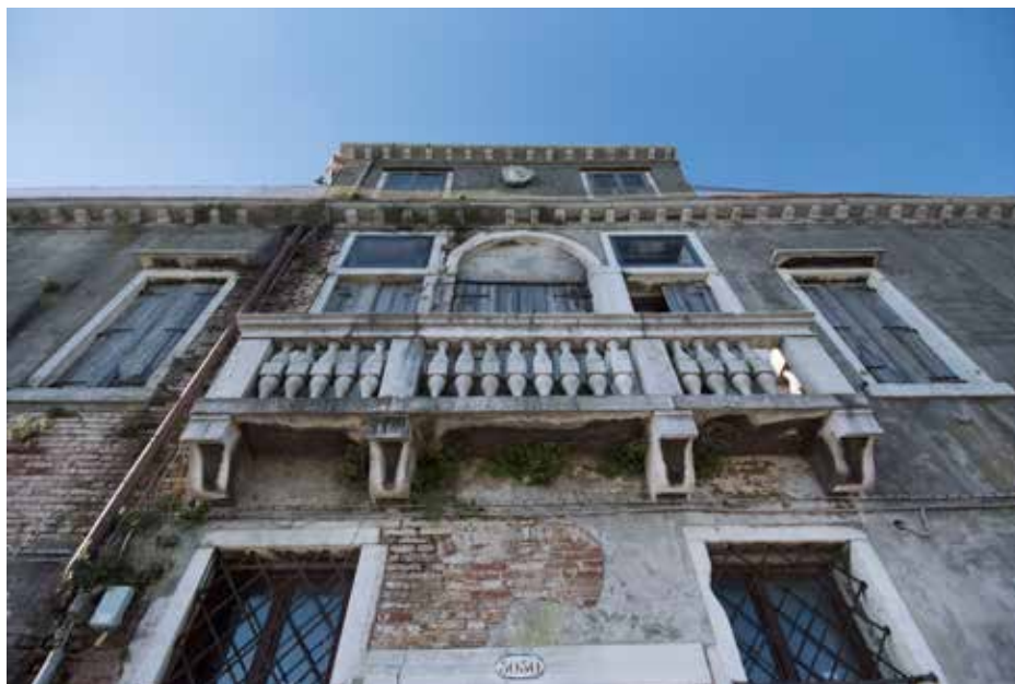
16. Palazzo ad ovest, prospetto verso le Fondamenta Nuove.
