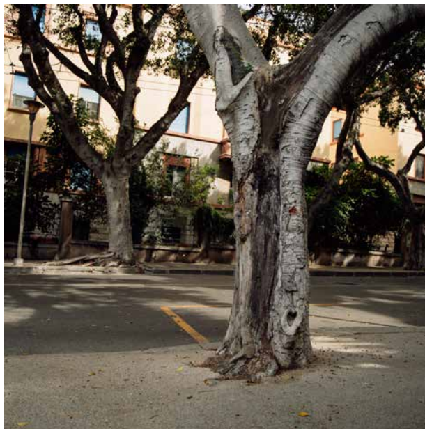
Viale Merello, sperimentazione di nuove pavimentazioni porose che permettono all'apparato radicale un contatto naturale col suolo e evitano il loro emergere in superficie (foto di Gabriele Muscas).
