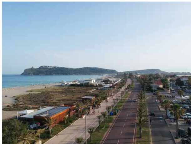
Ordinata sezione ciclopedonale e carrabile della via lungo la spiaggia del Poetto, secondo la moderna sistemazione (foto di Dietrich Steinmetz).
