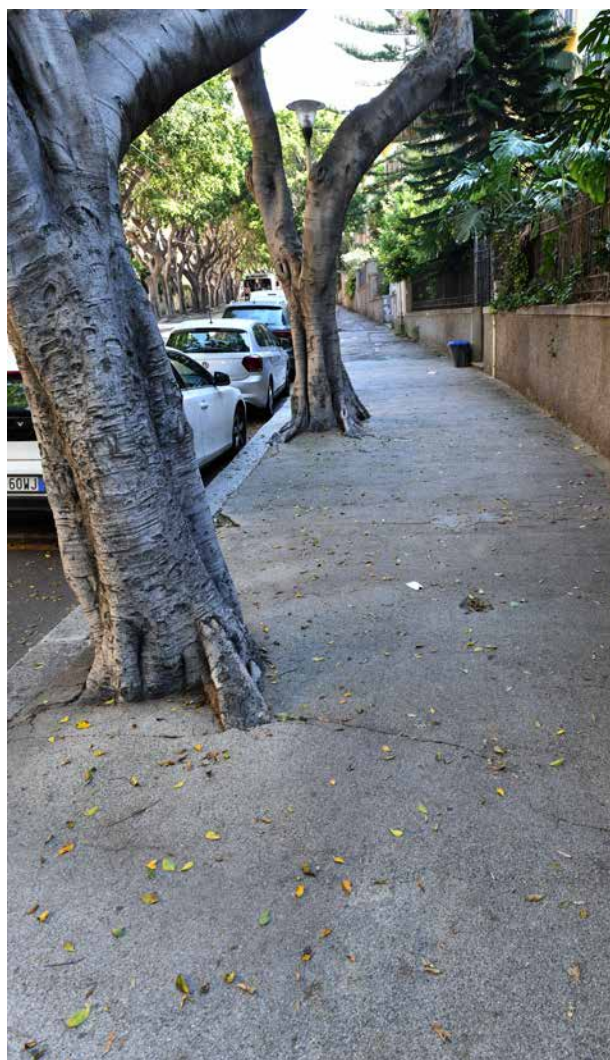
Viale Merello, marciapiede con pavimentazione drenante (foto di Dietrich Steinmetz).
