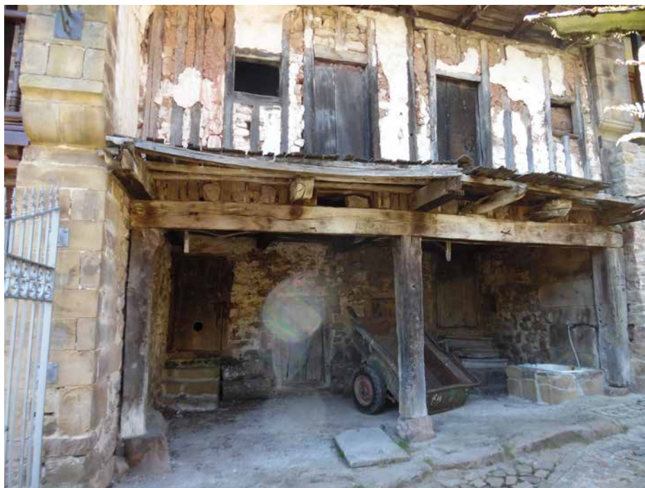
10. Casa tradicional en Barcena Mayor. Fachada a calle. Posee una estructura de madera independiente de los muros laterales. Fotografía del autor.
