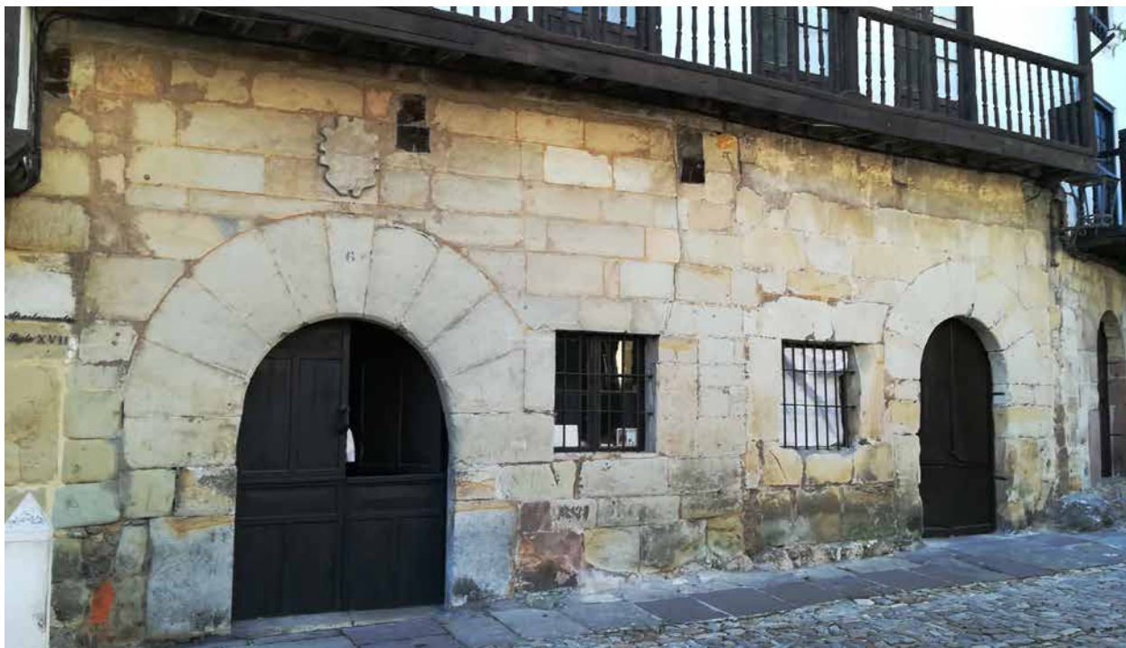
7. Casa en calle Juan Infante número 6. Se aprecian las cabezas seccionadas de las antiguas jácenas que soportaban el vuelo, Fotografía del autor.
