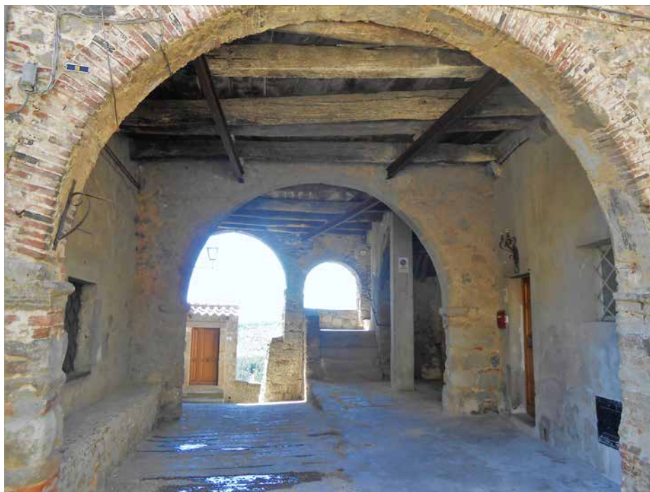
10. La Loggia del Liscio, già con forno e bottega nel 1825, Santa Fiora.
