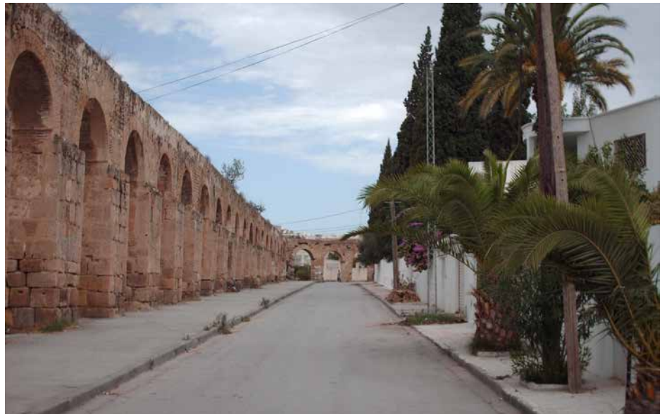
10. L'acquedotto di Bardo, Tunisia (foto Meriem Ben Ammar). La conformazione attuale si deve a un'aggiunta del sultano Hafside al-Mustancir fra il 1250 e il 1267 nell'ambito dei grandi lavori di restauro dell'acquedotto di Cartagine per riportare l'acqua a Tunisi e, soprattutto, per rifornire d'acqua il giardino di Abu Fihir. Il restauro dell'acquedotto e l'aggiunta sono stati realizzati in terra battuta "ṭābiya".
