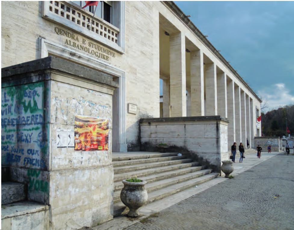
6_Tirana, complesso della Casa della Gioventù del Littorio Albanese (Gherardo Bosio Ferrante Orzali e Ferdinando Poggi, 1939-1941) sul fondale est dell'asse trasversale di Piazzale Littorio, con il portico per l'accesso al retrostante piazzale dello Stadio (foto E. Sessa, 2011).
